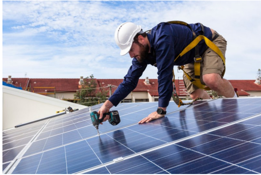
Trabajos en cubiertas.
