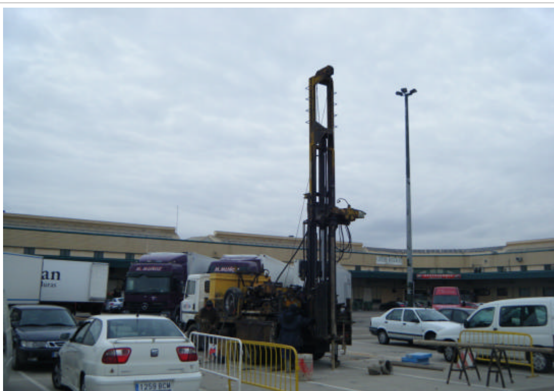
Máquina de sondeos en emplazamiento S-1
